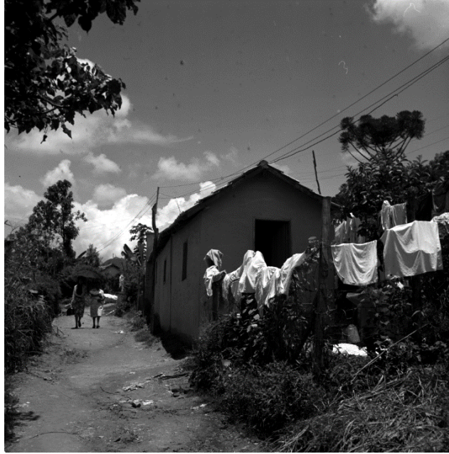
Figura 1: foto da favela Pindura Saia, Mazonni e Mazonni 1961. Acervo do Laboratório Sylvio de Vasconcellos da Escola de Arquitetura da UFMG.
