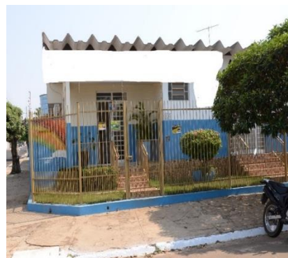
Figura 12: Fachada da Creche 2
