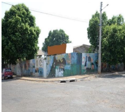
Figura 11: Fachada da Creche 1
